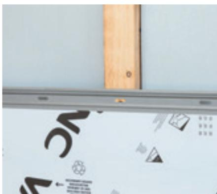
À l'aide d'un niveau, on vérifiera régulièrement, au fil de la pose, que les profils sont toujours parfaitement horizontaux.
