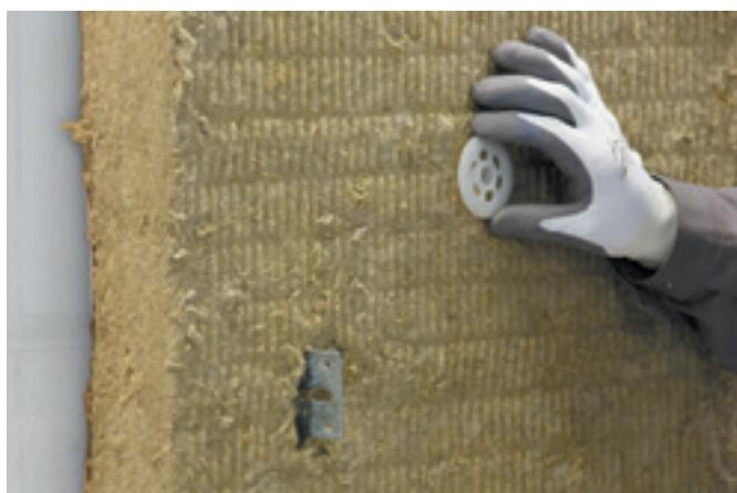
La ventilation de la face arrière des panneaux doit être assurée par une lame d'air d'épaisseur 2 cm minimum. Il est important d'assurer l'entrée, la sortie et la circulation de l'air sur toute la surface du bardage.
