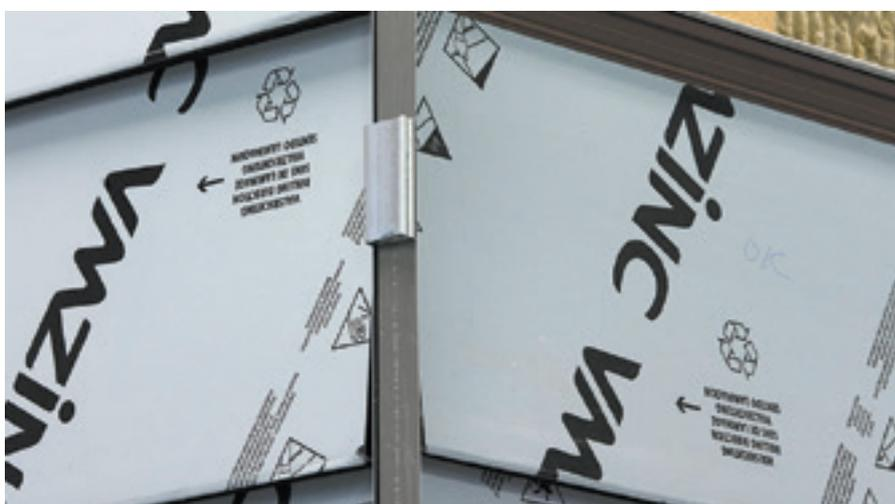
Enclencher les angles directement dans les clips. On procède à l'identique pour les angles rentrants.
