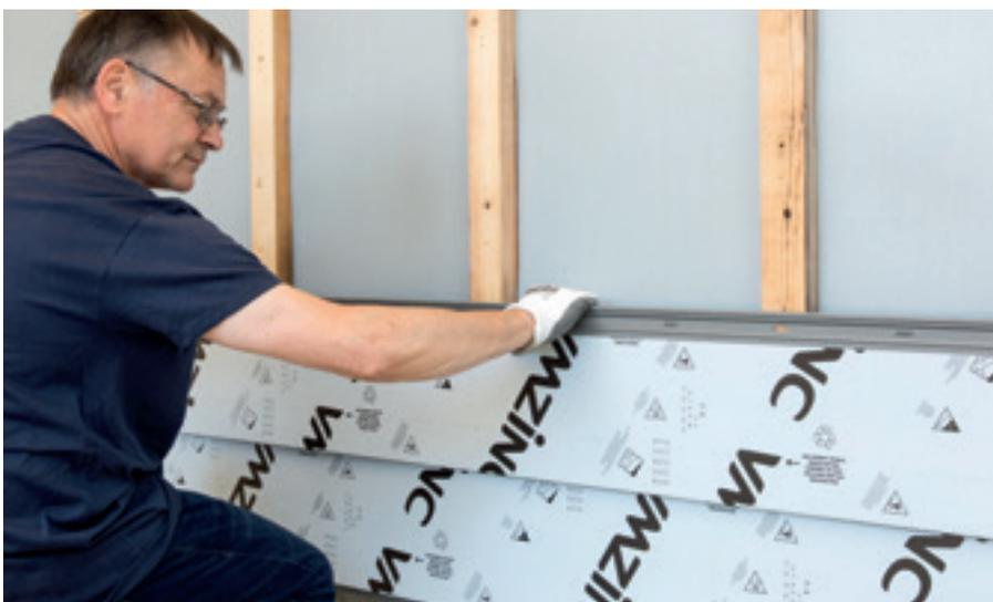
L'emploi de rondelle d'étanchéité permet de gérer la dilatation. Le couple de serrage doit être modéré.
