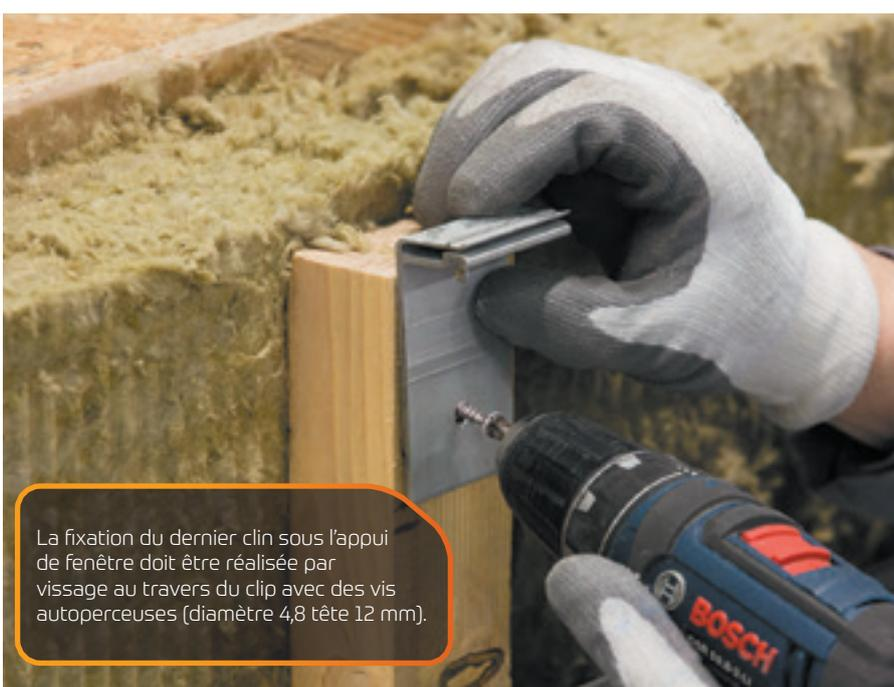
La fixation du dernier clin sous l'appui de fenêtre doit être réalisée par vissage au travers du clip avec des vis autoperceuses (diamètre 4,8 tête 12 mm).
